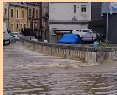
Inondations de juillet 2021 sur le pont situé à proximité des travaux
