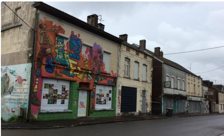
Quartier Sous Bois à Maubeuge
