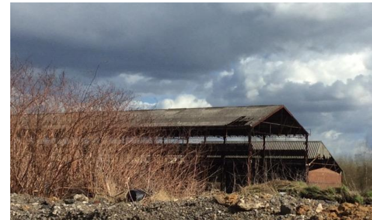
Hangar désaffecté à Feignies
