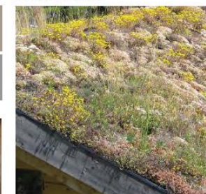
Les toitures végétalisées
