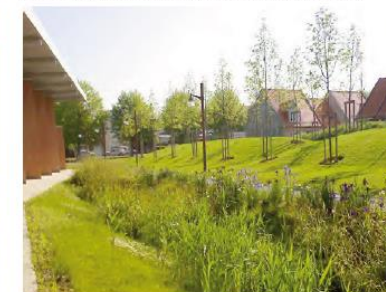
Gérer les eaux pluviales à grande échelle et de manière paysagère
