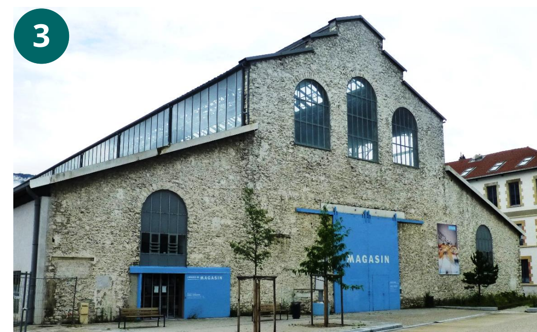
Le Magasin, édifice industriel reconverti en équipement culturel, Grenoble
