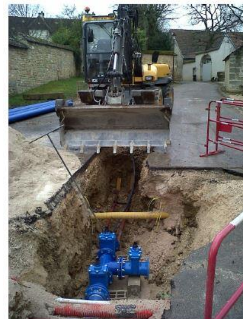
Travaux de renouvellement sur Fixin
