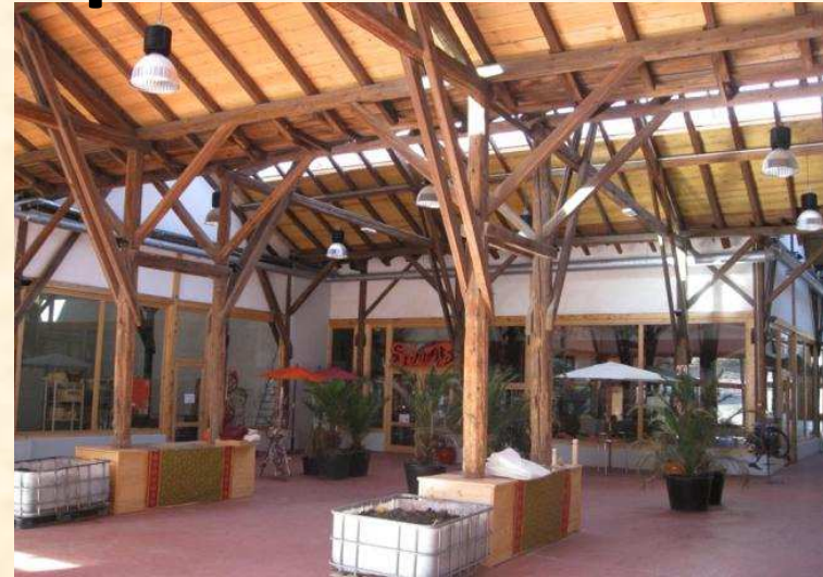
Intérieur du bâtiment
