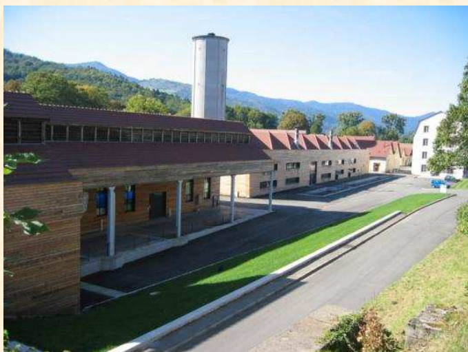
Hall stockage / logistique
