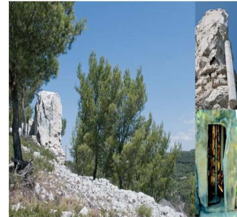
Cassis (Bouches-du-Rhône), massif boisé L'antenne est placée à l'intérieur d'un rocher en polyester et fibre de verre. On y accède par une porte latérale.
