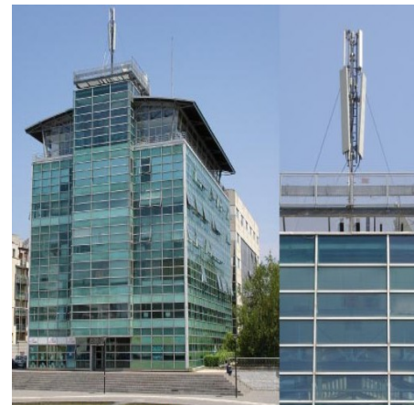
Suyancourt (Yvelines), immeuble de bureaux L'architecte a conservé l'esprit élancé et dynamique de la façade en disposant les antennes sur une structure verticale centrale la plus fine possible.
