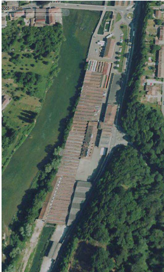
1 – état de la partie sud du site en 2006
