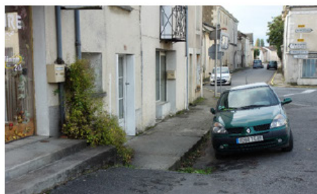
2-Présence d'un fort dévers vers le bâti situé à l'est de la place : jusqu'à 70 cm avec des pentes à 8%
